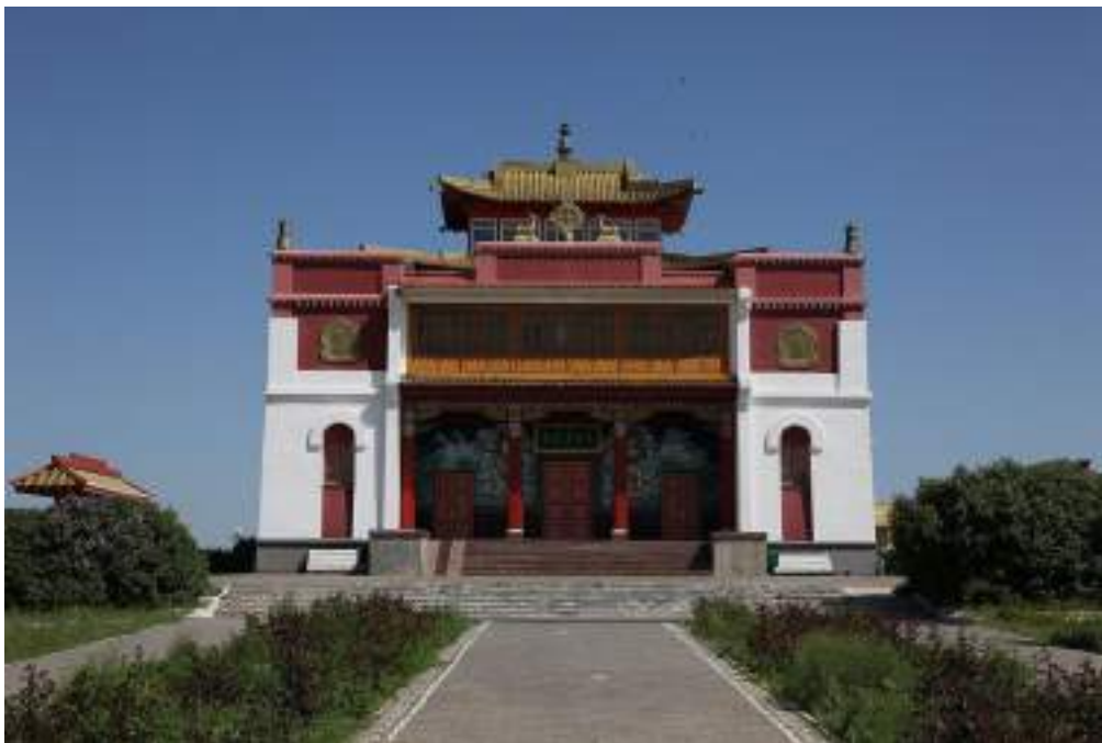
Хурульный комплекс «Сякюсн-сюме». Построен в 1996 г. по проекту В. Гиляндикова.
