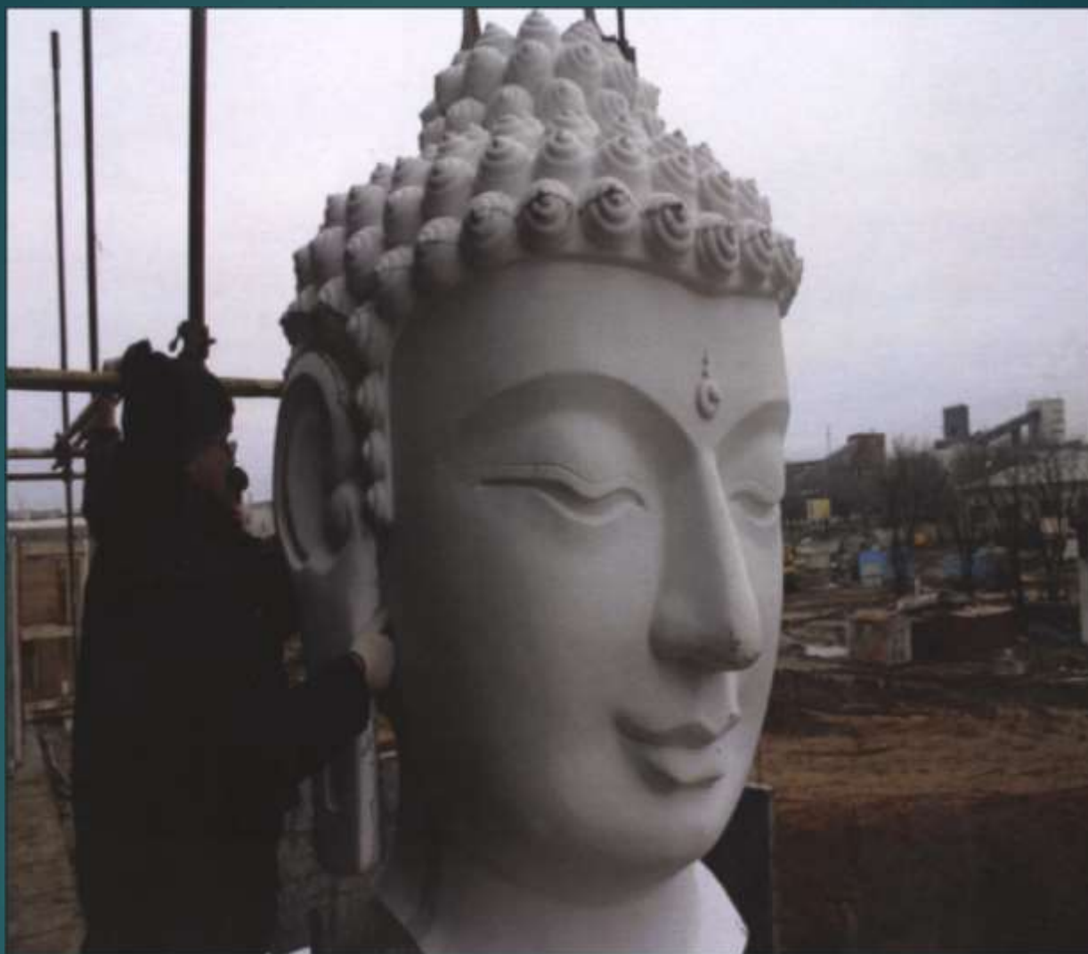
Голова Будды. Рабочий момент монтажа.
